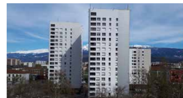
Les "3 tours" de l'avenue Rhin et Danube à Grenoble
